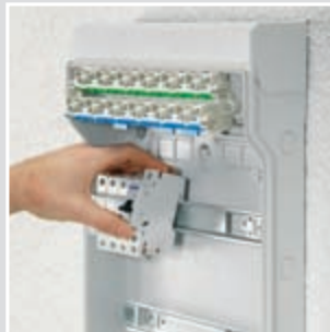
Dostatek místa pro instalaci přístrojů a zapojování: snadný přístup pro montáž přístrojů při umístění rozváděče na nižší místo.
