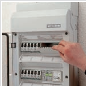
12 až 54 modulů: přiložené pásky k zakrytí otvorů neobsazených přístroji na DIN lištu.
